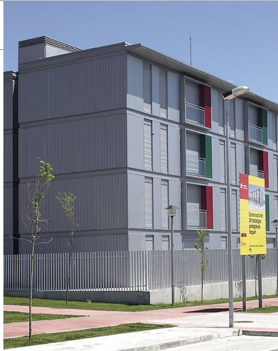
Edificio en Torelló. Calle del Compte Borrell. UTE IMAPRO
