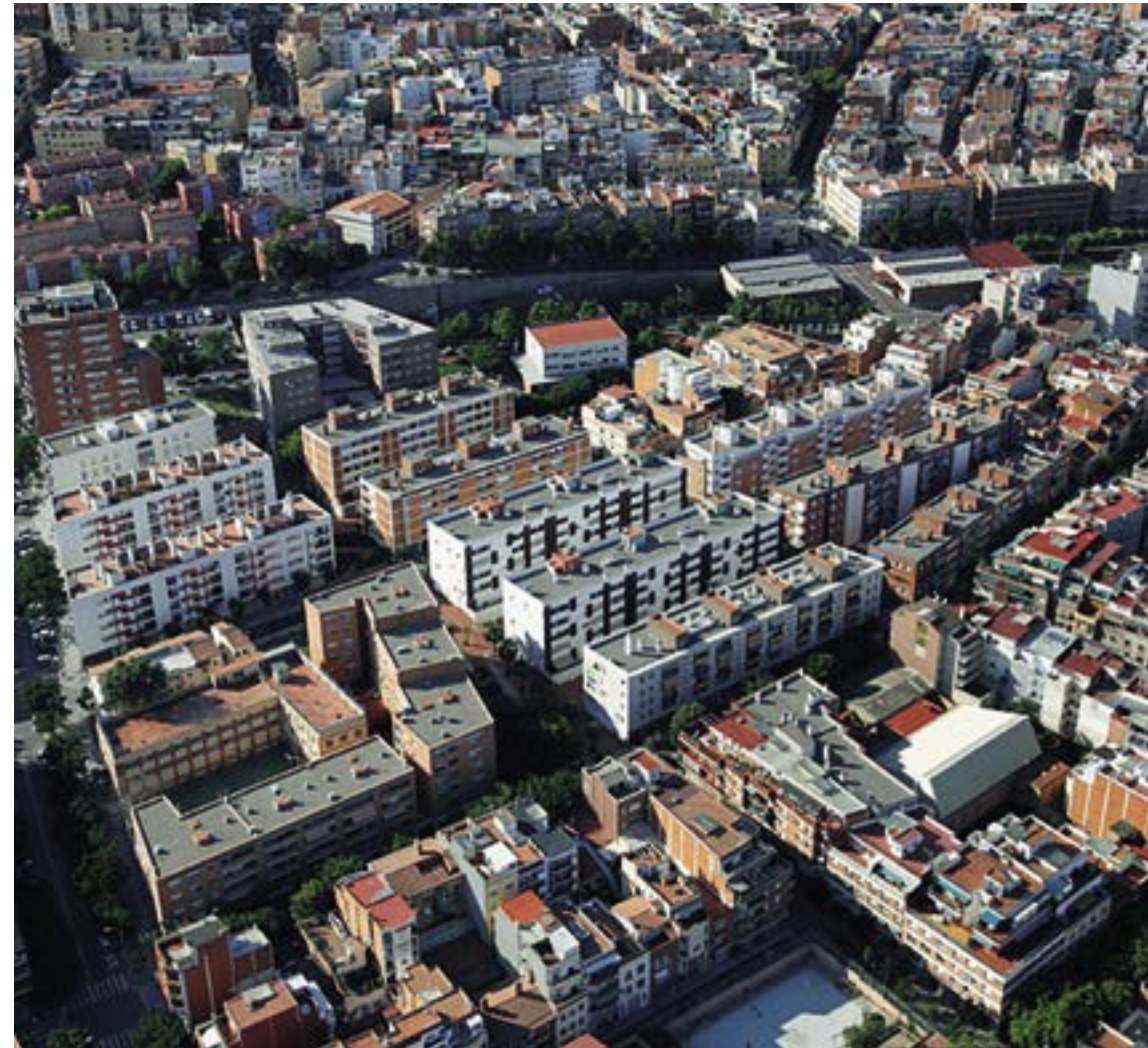
Vista aèria del conjunt de les Cases del Governador. Verдум, Nou Barris, Barcelona
