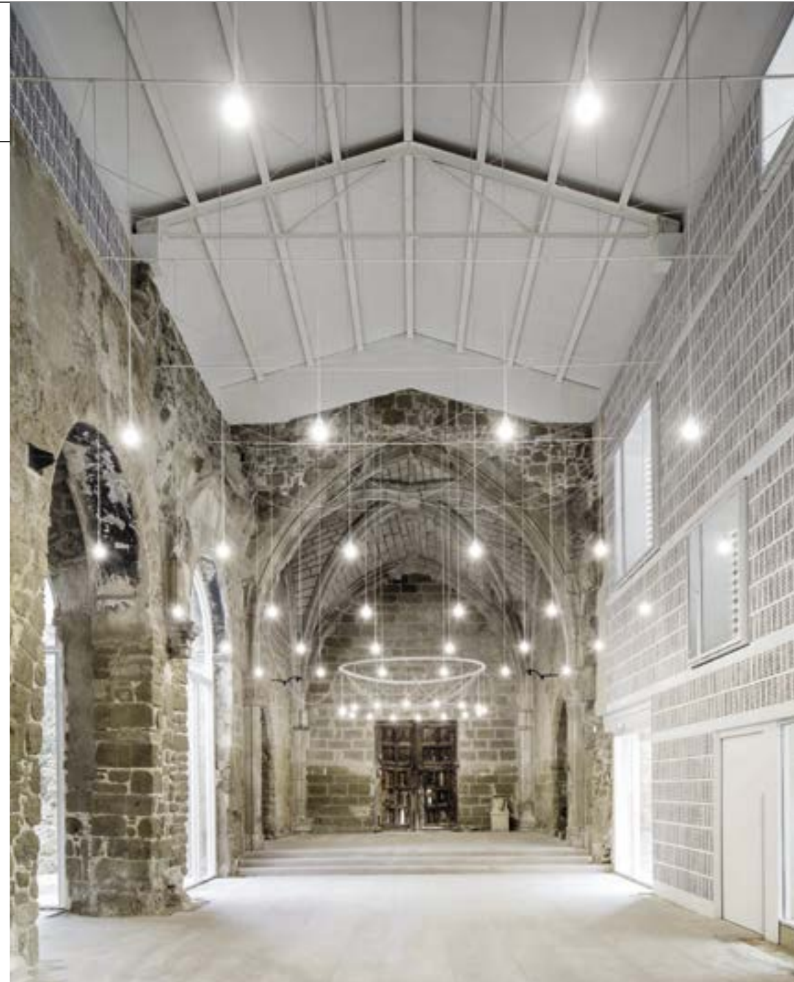
Rehabilitació de l'antiga església vella de Vilanova de la Barca. Foto: Adrià Goula
