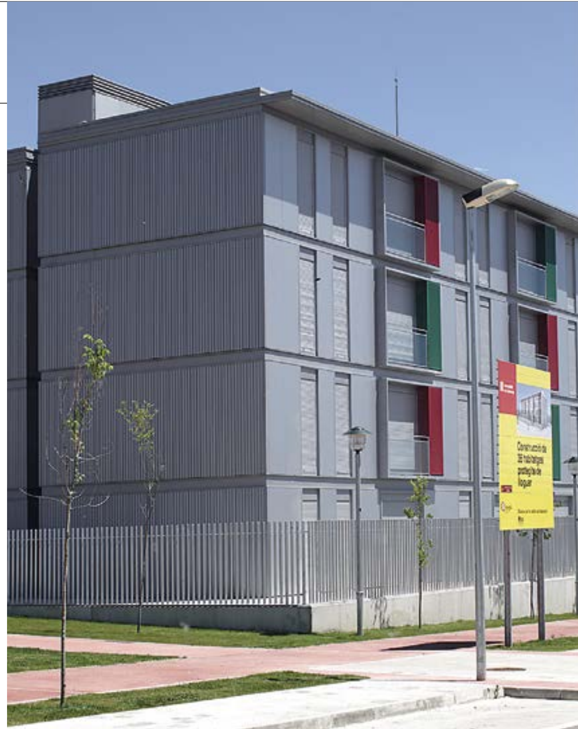
Edifici a Torelló al Carrer del Compte Borrell. UTE IMAPRO
