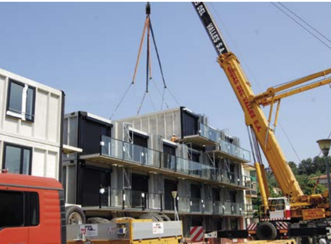
Edifici modular de 30 habitatges de protecció oficial a Banyoles
