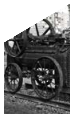
1.0 Generació de vapor
