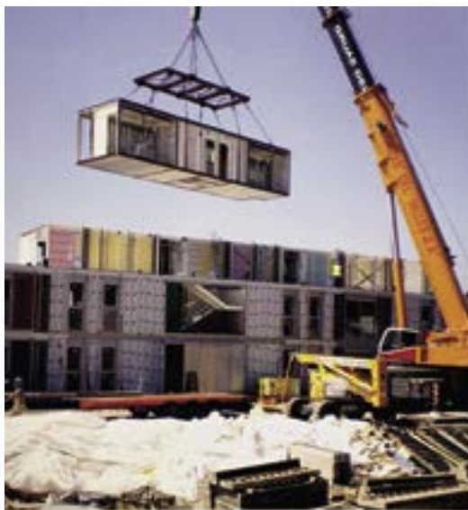
↑ Noves tècniques constructives en un edifici de Banyoles
