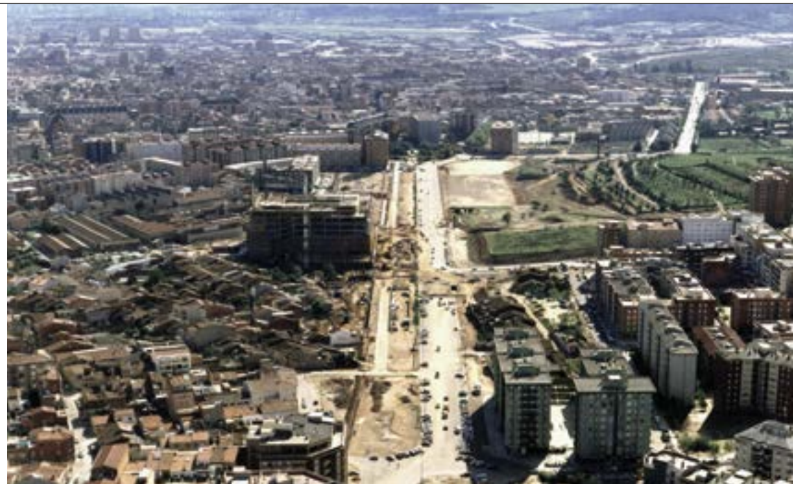
L'Eix Macià de Sabadell en construcció
