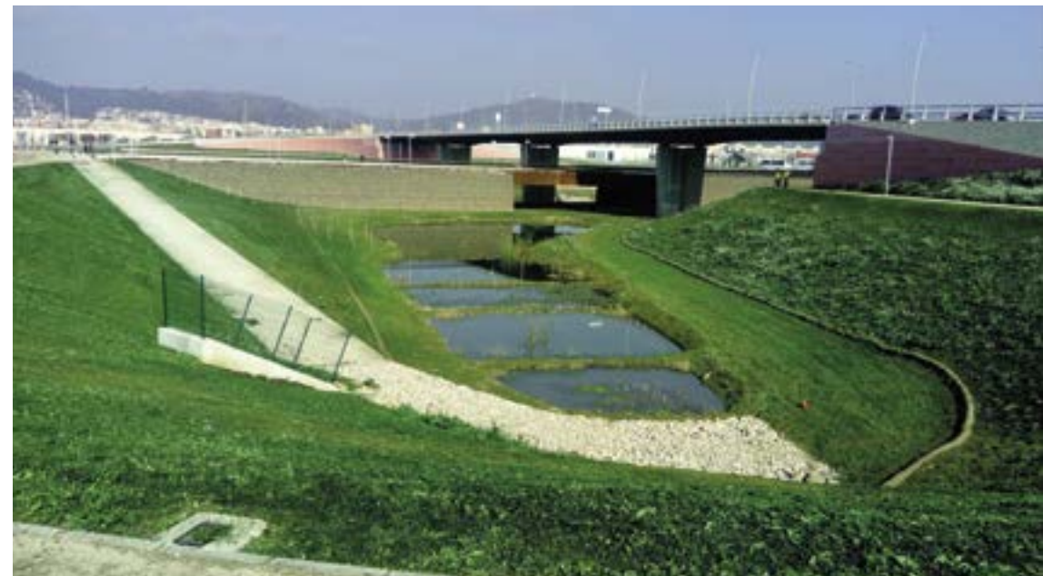
Bassa de laminació de Ca n'Alemany a Castelldefels
